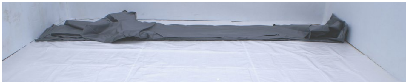
Abbildung 35 – Entfalten der Folienauskleidung
