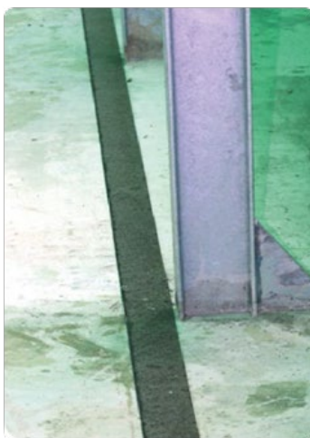
Abbildung 9 – Anbringen der Bitumenstreifen
