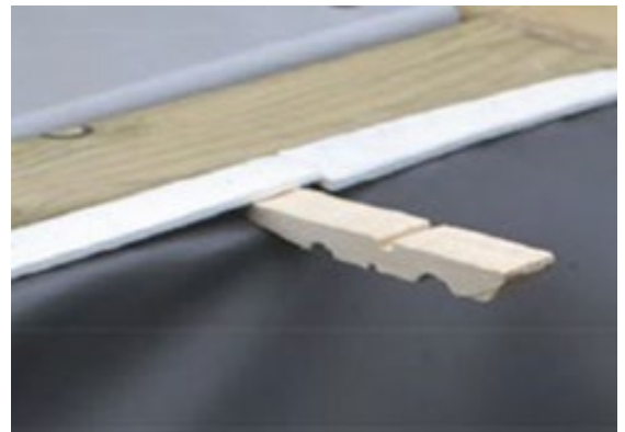
Abbildung 34 – Verlegung der Folienauskleidung mithilfe der halben Wäscheklammern
