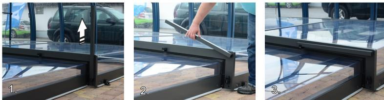
**Beilage 4A - Entriegelung der Windsicherung**
