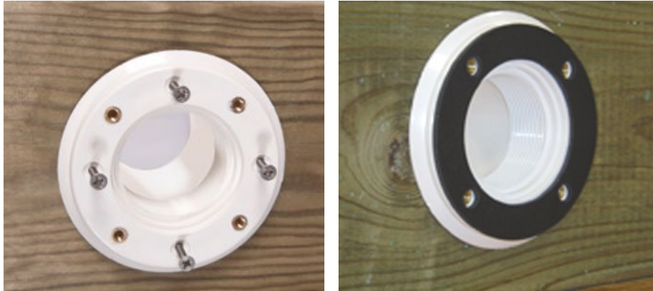
Abbildung 24 – Montage der Ausstoßdüse und seiner Dichtung
