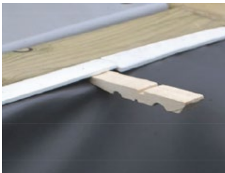
Abbildung 32 – Verteilung der Folienauskleidung mithilfe der halben Wäscheklammern
