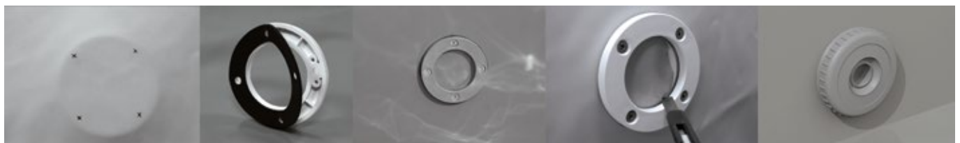
Abbildung 35 – Anbringen des Flansches am Rücklauf
