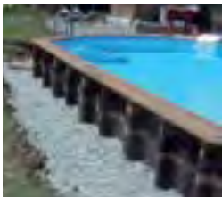
Drainage gravel Grava drenante Gravier drainant Kies zur Entwässerung Ghiaia drenante Steenlag/grind voor drainage Brita drenante
