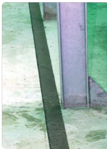
Abbildung 7 – Schaffung der Bitumenstreifen
