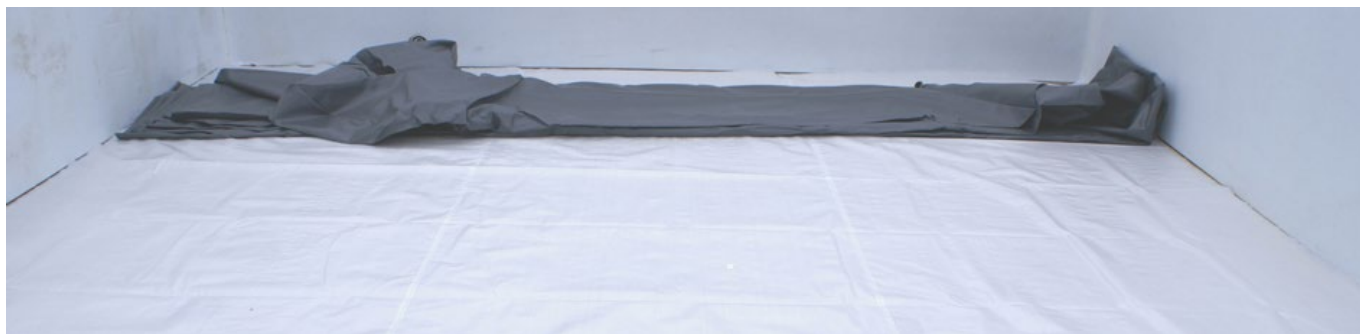
Abbildung 27 – Entfalten der Folienauskleidung
