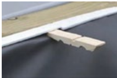
Abbildung 28 – Verklebung der Folienauskleidung mithilfe der halben Wäscheklammern
