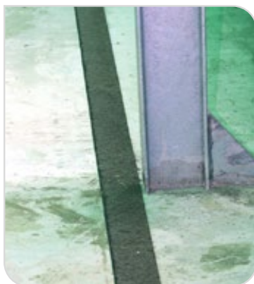
Abbildung 15 – Bitumenstreifen
