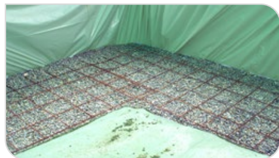
Abbildung 3 – Boden des Aushubs
