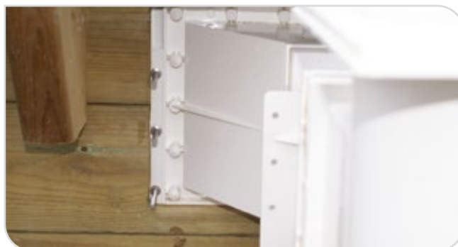
Befestigung des Skimmers
