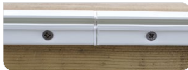
Abbildung 28 – Klemmprofil bündig mit der Beckenoberkante abschließen
