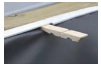
Figure 22 – Verrouillage du liner grâce à des demi épingles à linge
