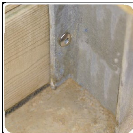
Abbildung 8 – Verschraubung der Bohlen auf den Streben
