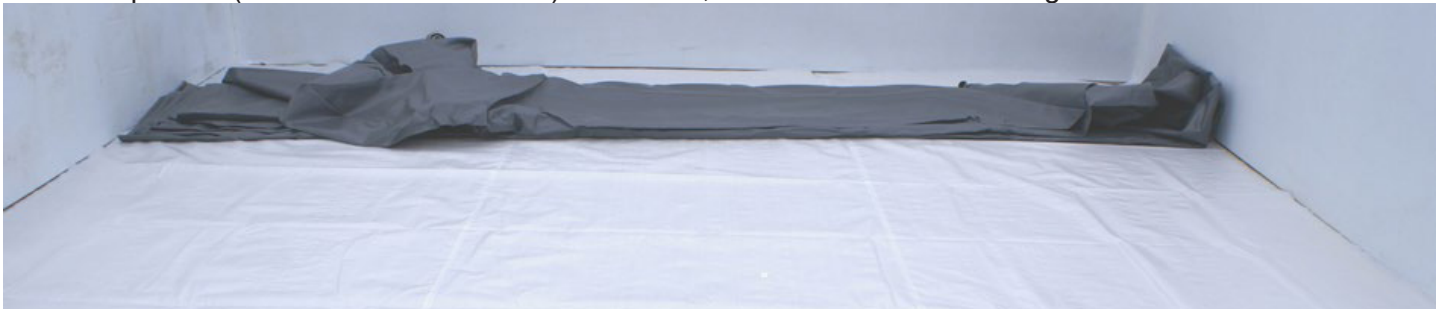
Abbildung 21 – Entfalten der Folienauskleidung
