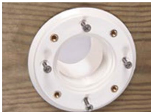
Abbildung 15 – Montage der Wanddurchführungen
