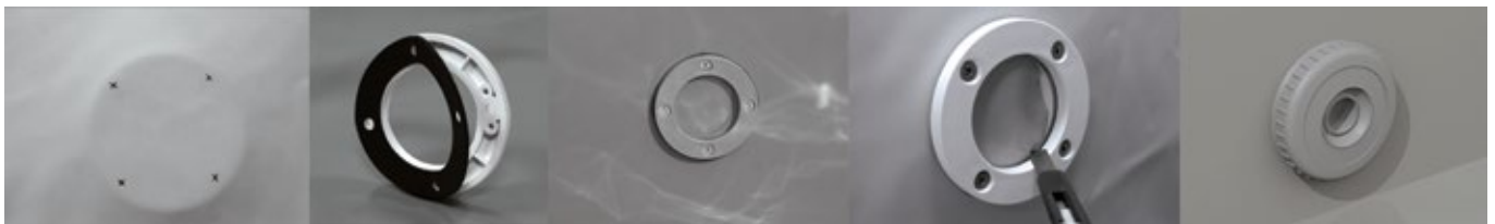
Abbildung 35 – Anbringen des Flansches am Rücklauf
